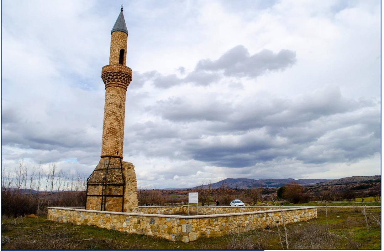
Şekil 10: Kayı Pazarı Camii Minaresi
